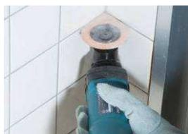
**L'enlève mortier, le plateau de ponçage à concrétion et les lames segments spécifiques** conviennent au déjointage de carrelage et à l'élimination de mortier...
